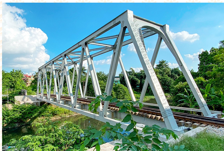
Cầu Ghênh (cầu đường sắt) ngày nay
